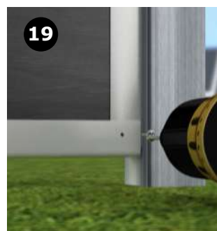
18 Skru skruer i hvor hullerne tidligere blev lavet, her skrues også igennem hegnsp profileren
