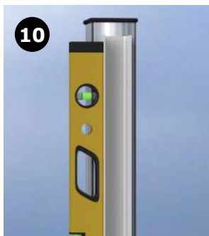
10 Placer sideprofiler på stolpen - Tjek om de er i lod
