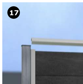
17 Montér din topskinne
