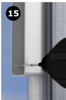
14 Bor huller gennem sideprofilen med 3mm bor.
