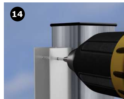
14 Bor huller gennem sideprofilen med 3mm bor.
